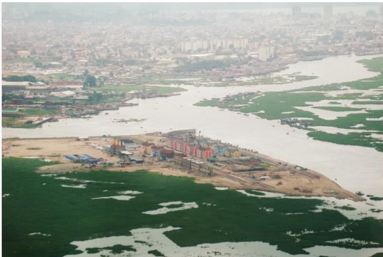
Kinshasa, la Cité du Fleuve , veduta aerea
